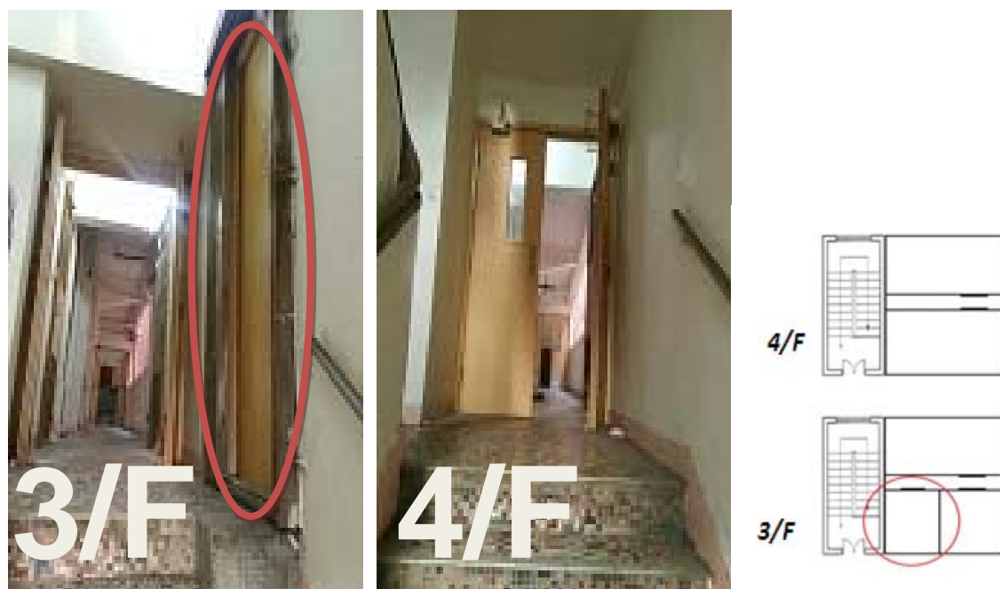
圖 3.3 分間樓宇單位的例子(三) Diagram 3.3 Example (3) of subdivided units
